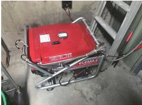
圖 5-2-11、全自動汽油式發電機
