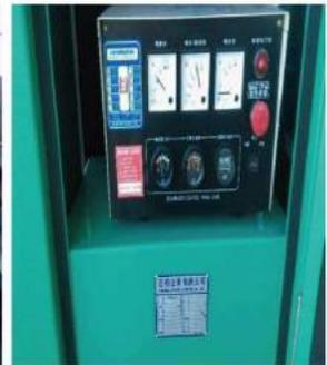
圖5-20 全自動柴油式發電機操作系統
